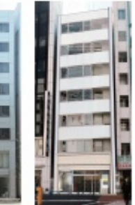
四ッ谷プラザビル
