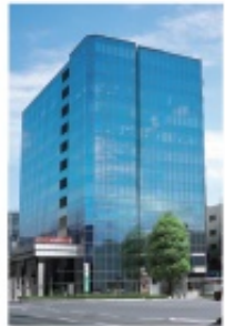
名古屋 センタープラザビル
