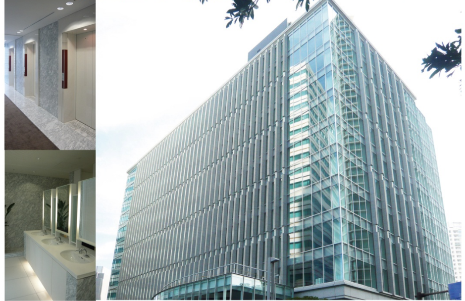
横浜プラザビル
