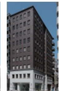
九段下プラザビル
