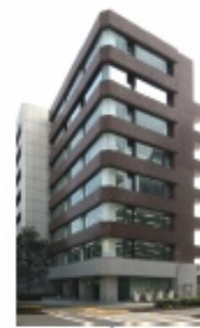
幡ヶ谷プラザビル
