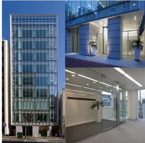
築地プラザビル
