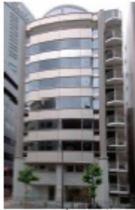
芝公園プラザビル
