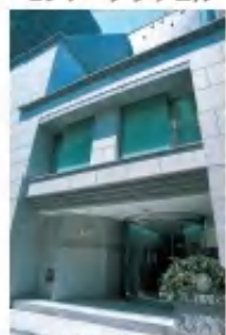
西新橋プラザビル
