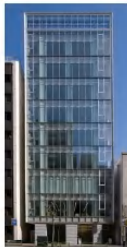
築地プラザビル
