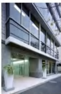
新橋プラザビル
