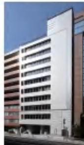
芝プラザビル
