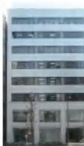
神田プラザビル
