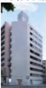
東神田プラザビル
