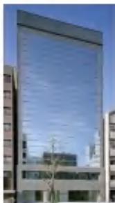
名古屋丸の内 プラザビル
