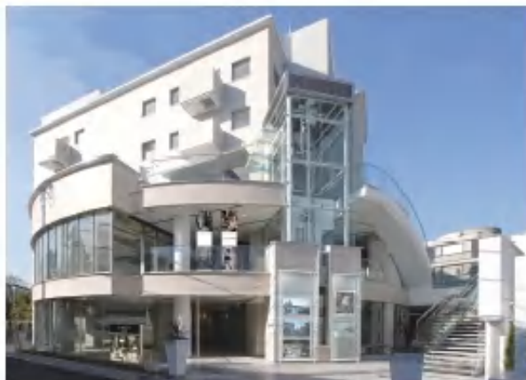
イル・チェント口表参道
