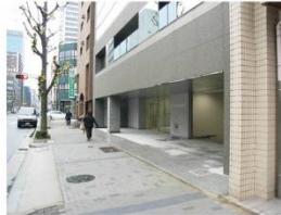
名古屋丸の内プラザビル
