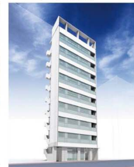
築地プラザビル
