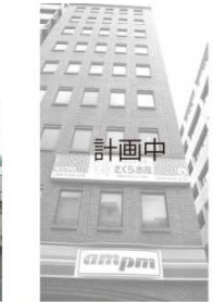
九段プラザビル
