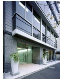
新橋プラザビル
