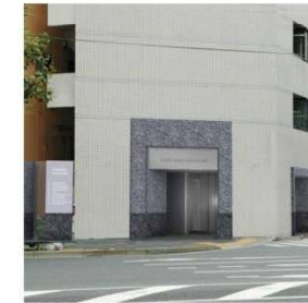
東神田プラザビル
