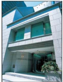
西新橋プラザビル
