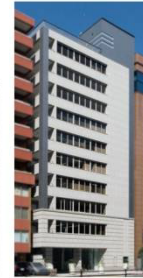
芝プラザビル
