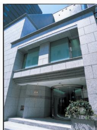
西新橋プラザビル
