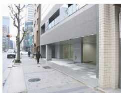
名古屋丸の内プラザビル
