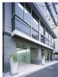
新橋プラザビル
