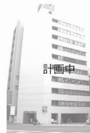
東神田プラザビル
