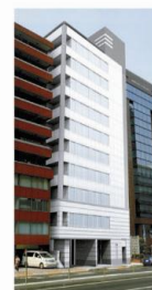
芝プラザビル
