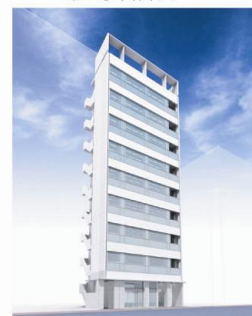
築地プラザビル
