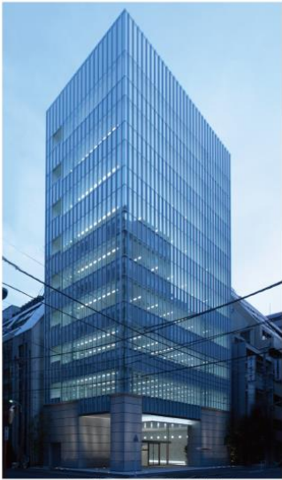
日本橋大伝馬町プラザビル
