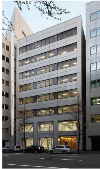
神田プラザビル
