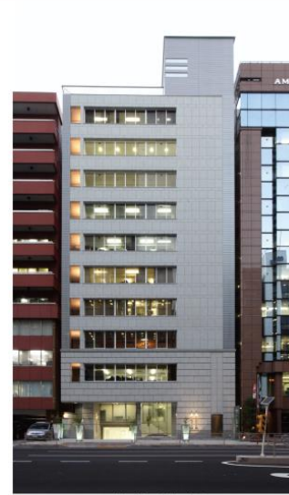
芝プラザビル
