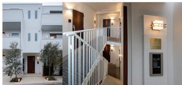
ソサエティ駒沢 (新築)
