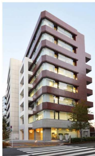
幡ヶ谷プラザビル
