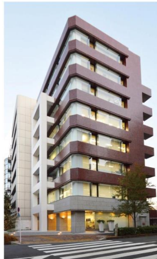
幡ヶ谷プラザビル
