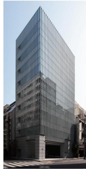
日本橋大伝馬町プラザビル
