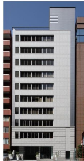
芝プラザビル
