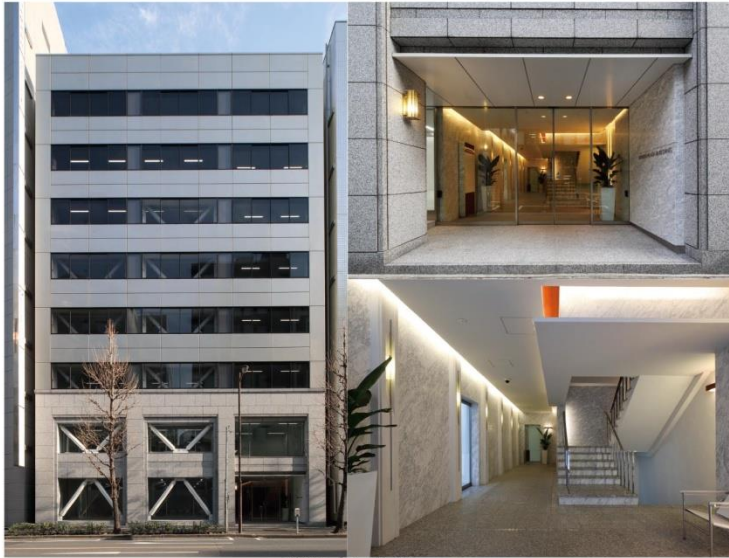
神田プラザビル
