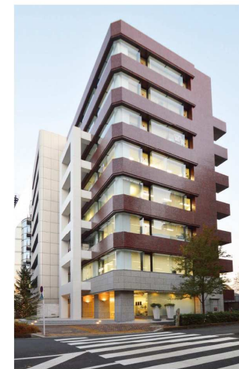
幡ヶ谷プラザビル
