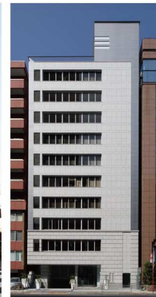
芝プラザビル
