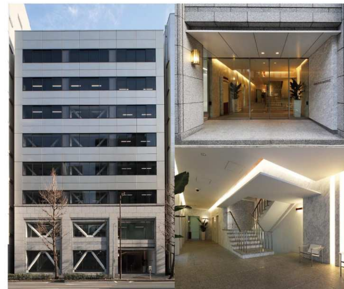
神田プラザビル
