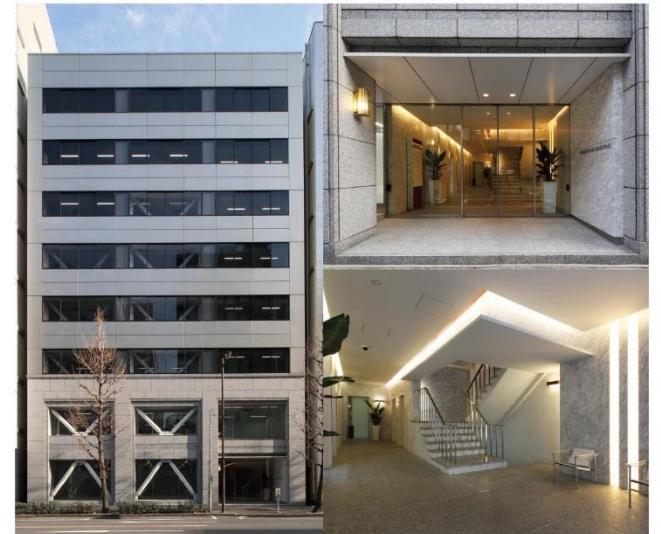
神田プラザビル
