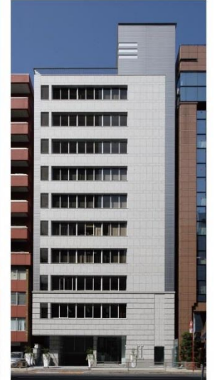
芝プラザビル
