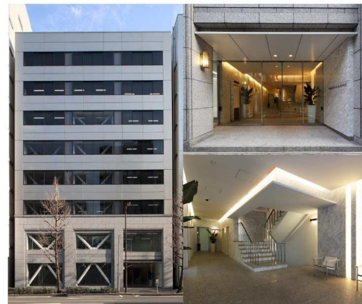
神田プラザビル
