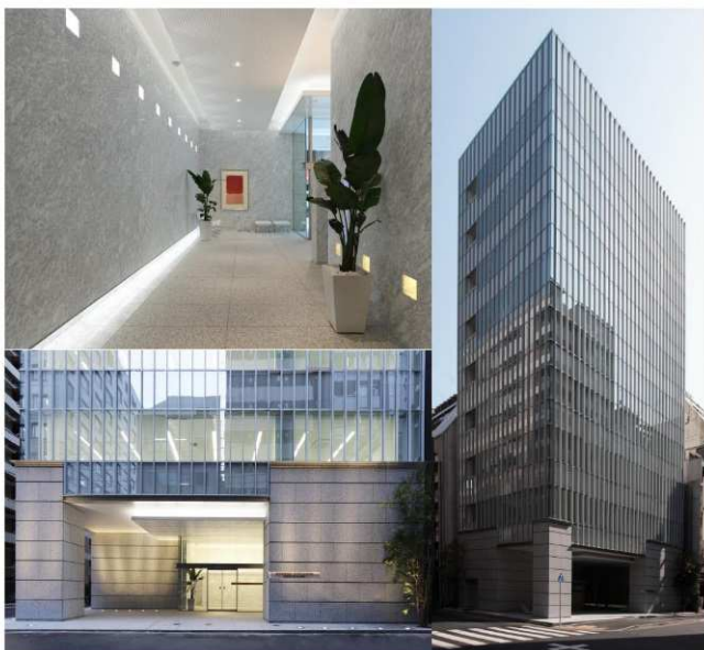
日本橋大伝馬町プラザビル
