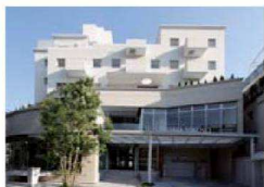
イル・チェントロ表参道
