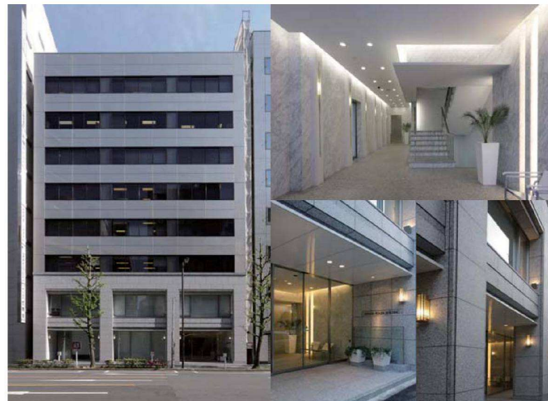
神田プラザビル
