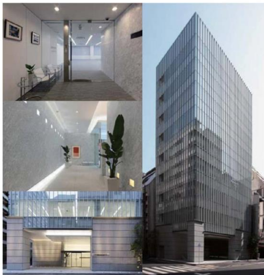
日本橋大伝馬町プラザビル
