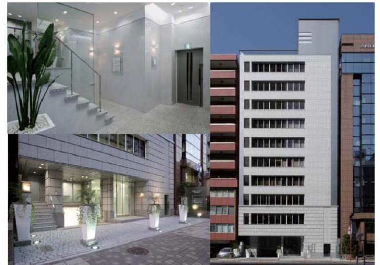
芝プラザビル
