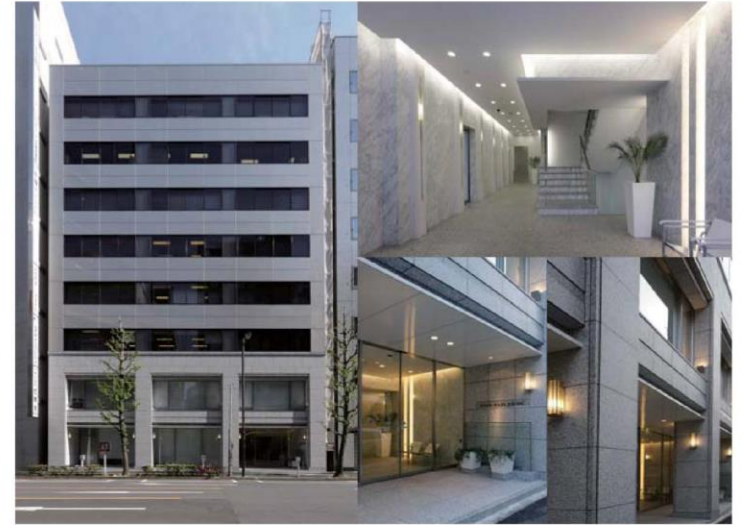
神田プラザビル
