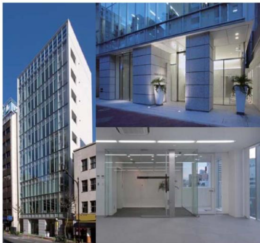
築地プラザビル
