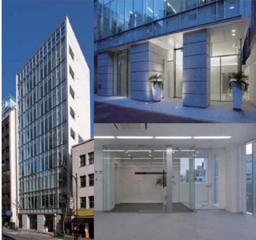
築地プラザビル
