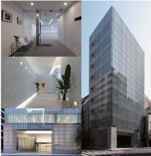
日本橋大伝馬町プラザビル
