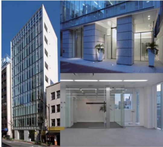
築地プラザビル
