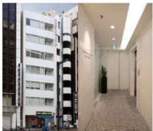
四ッ谷プラザビル
