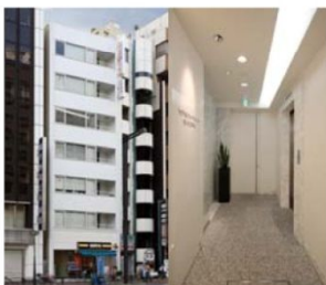
四ッ谷プラザビル
