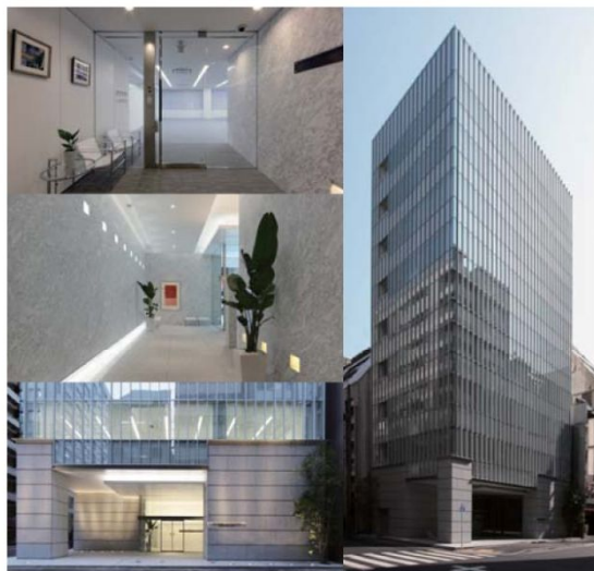
日本橋大伝馬町プラザビル
