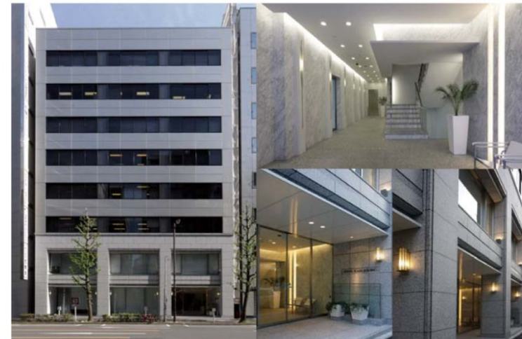
神田プラザビル
