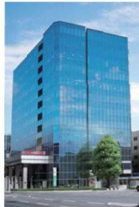
名古屋 センタープラザビル
