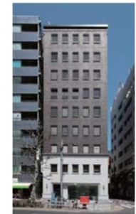
九段下プラザビル
