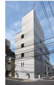
三田 シティプラザビル
