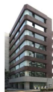
幡ヶ谷プラザビル
