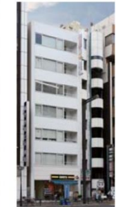
四ッ谷プラザビル
