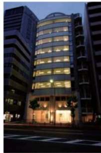
芝公園プラザビル
