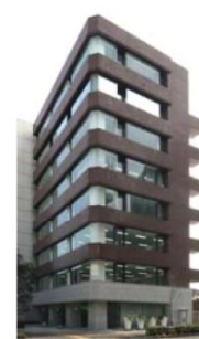
幡ヶ谷プラザビル
